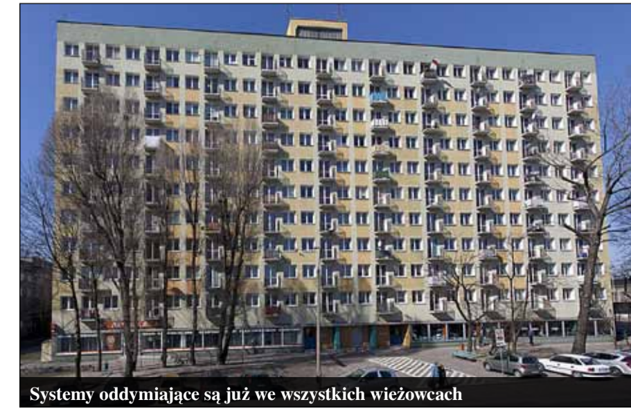
Systemy oddymiające są już we wszystkich wieżowcach
