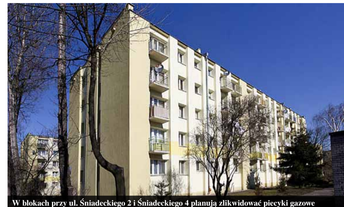
W blokach przy ul. Śniadeckiego 2 i Śniadeckiego 4 planują zlikwidować piecyki gazowe
