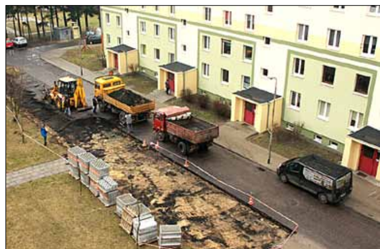
ul. Dolna 21: w tym roku przybyło miejsc postojowych
