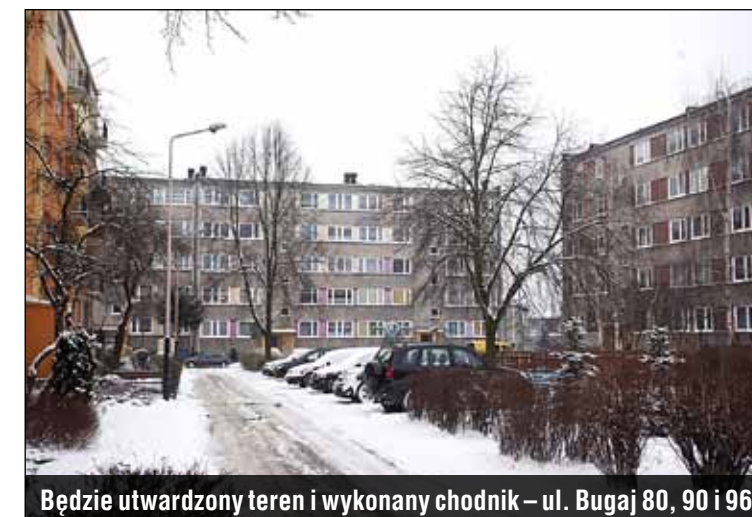
Będzie utwardzony teren i wykonany chodnik – ul. Bugaj 80, 90 i 96
