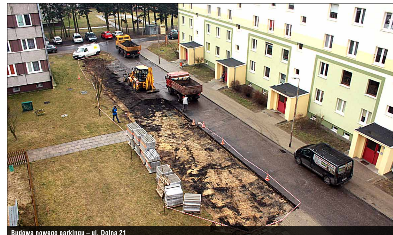
Budowa nowego parkingu – ul. Dolna 21
