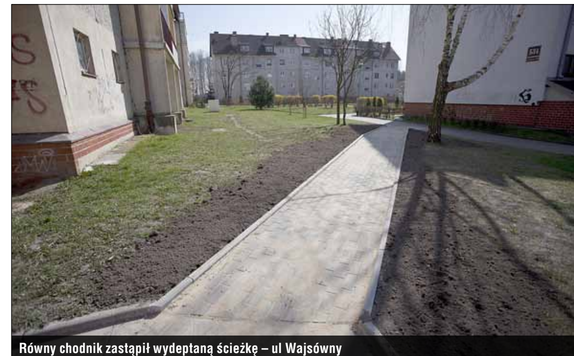
Równy chodnik zastąpił wydeptaną ścieżkę – ul. Wajsówny
