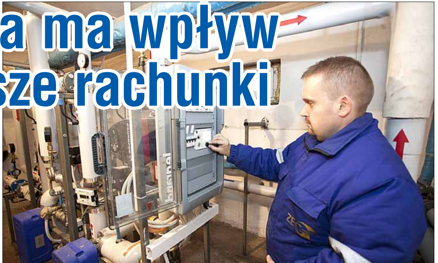
Adam Pawlikowski (ZEC) dogląda parametrów na węźle ciepła w bloku przy ul. Wileńska 65. Przez Zakład Energetyki Ciepłej zarządzanych jest 113 węzłów ciepła w blokach.
