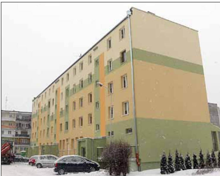
ul. Dolna 46, termomodernizacja
